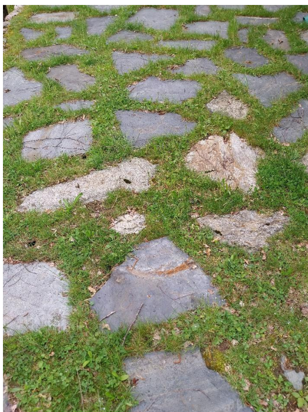
Pietra e terra mischiata a sabbia
