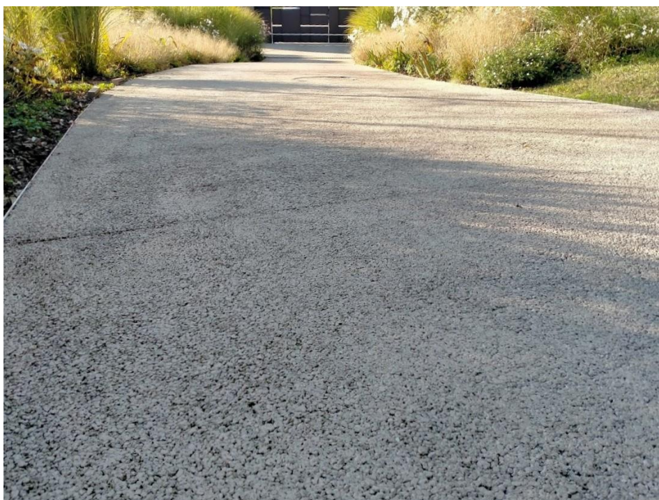
Calcestruzzo drenante con inerte di pezzatura media
