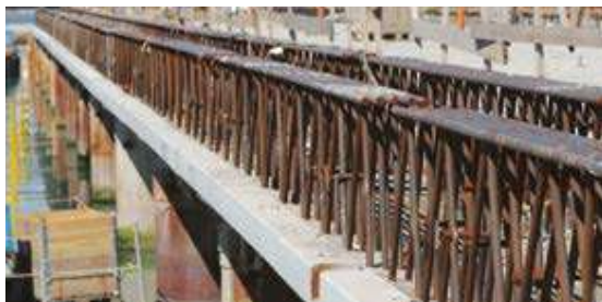
PARTICOLARE TRAVI RETICOLARI MISTE
