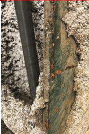
Esempio di protettivo spruzzato su struttura metallica. Il distacco mostra criticità legate alla posa errata. Il supporto non è stato correttamente preparato rendendo di fatto l'adesione non completa. Il prodotto ha subito urti meccanici che hanno determinato aree di distacco che, in assenza di manutenzione, non sono state ripristinate. Tutto questo rende, di fatto, il rinnovo di conformità non effettuabile
