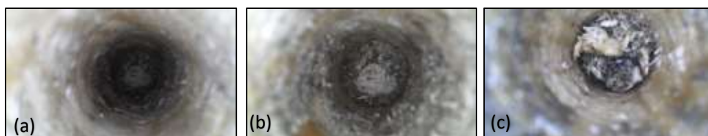
Figura 11 – “Foro 3” dell’attacco a terra. (a) Ingresso foro, rivestimento ed assito esterni. (b) Centro foro, isolante. (c) Fondo foro, corrente in legno.
