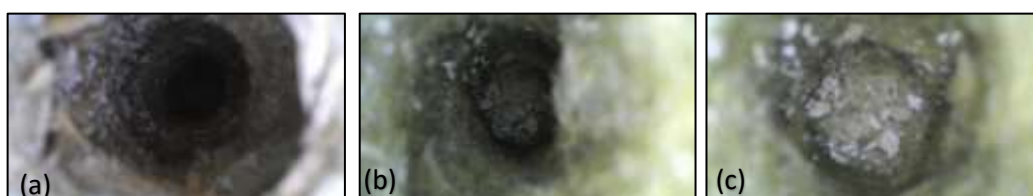
Figura 9 – “Foro 2” perpendicolare alla parete. (a) Ingresso foro, cartongesso. (b) Centro foro, isolante. (c) Fondo foro, pannello OSB della parete portante.
